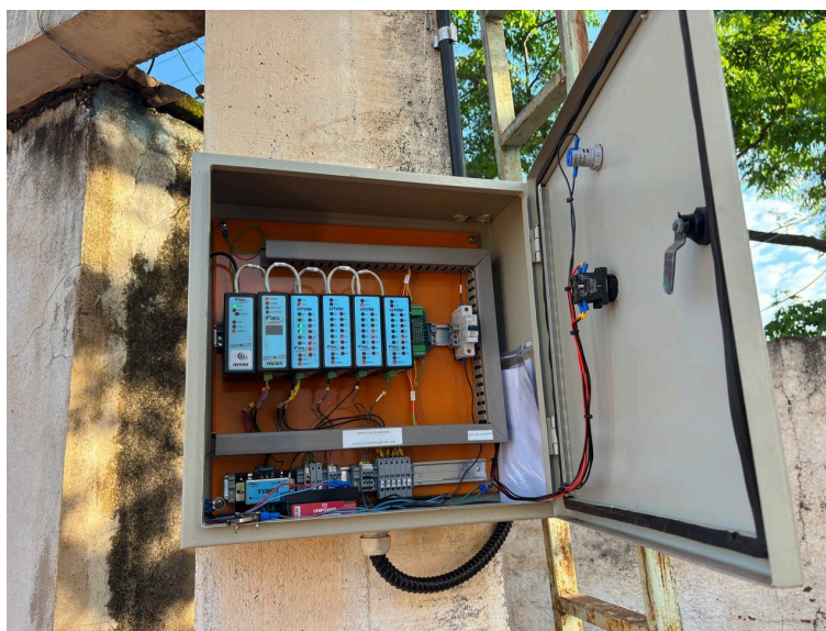
Figura 5: Painel de telemetria do Centro de Reservação São José, com os módulos ControlFlex.
