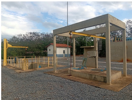
Figura 8: ETE Capoeirão — estação de tratamento de esgoto integrada ao sistema.
