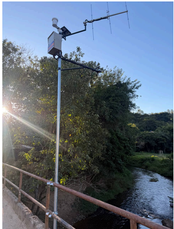
Figura 10: Estação na Ponte Vila Cafundão.
