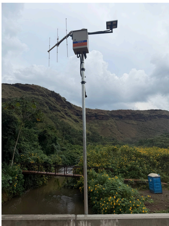
Figura 6: Estação na Ponte Mata Cavallo, sobre o córrego — o sensor de nível fica na estrutura da ponte, voltado para a lâmina d'água.
