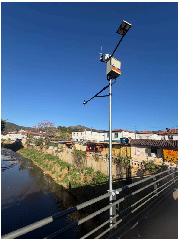
Figura 9: Estação na Ponte Terminal Turístico, área urbana.
