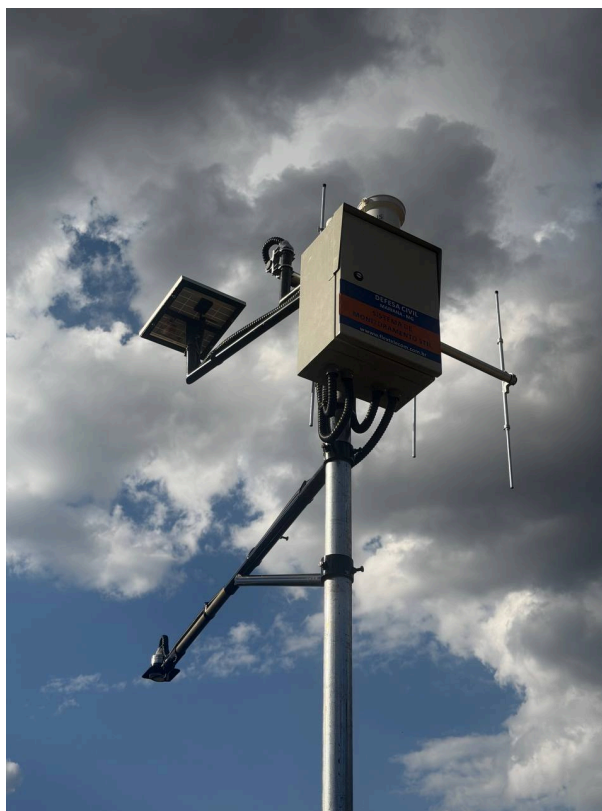
Figura 5: Estação de monitoramento hidrometeorológico — placa solar, pluviômetro, painel e antena.
